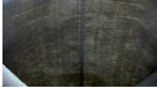
Vista a contraluz del interior de la bolsa. Se aprecia la pérdida de homogeneidad.
