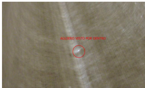
Fotografía superior: agujero visto desde la parte interior de la manga.
